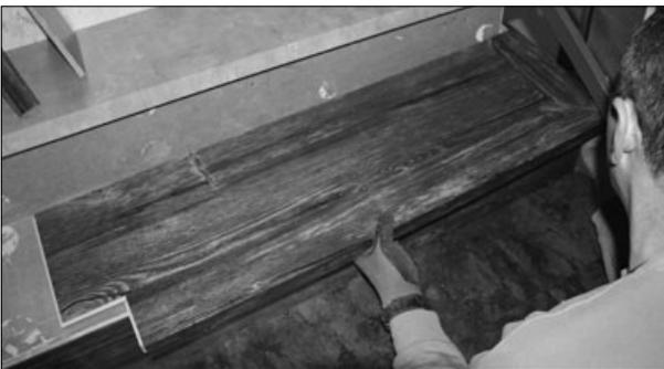
3. Coger la medida y cortar la pieza para colocar en la parte superior del escalón, usando el sistema clic si es posible, y sino, usando pegamento.
